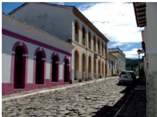
Calçamento irregular em pedra. Goiás/GO. 2013. Foto: Renata Ceridono Fortes.
