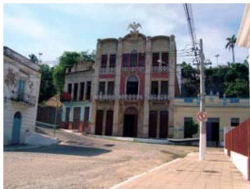
Calçadas e edifícios sem acessibilidade. Corumbá/MS. 2010. Foto: Renata Ceridono Fortes.
