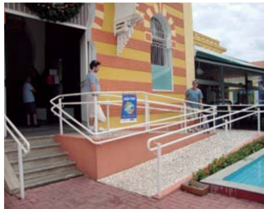
Rampa em mercado municipal de Amparo/SP. 2013. Foto: Sandra Bernardes Ribeiro.
