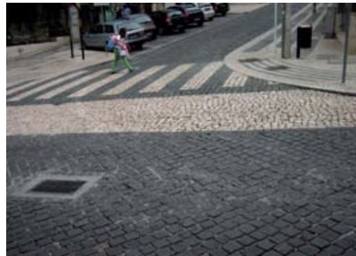
Calçadas e faixas de pedestres utilizando material em cores diferentes. Guimarães, Portugal. 2011. Foto: George Alex da Guia.
