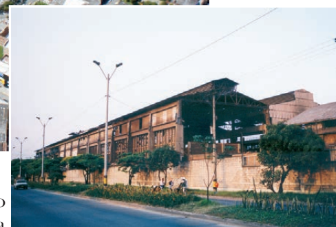
Vista aérea do projeto Simesa em Medellín, na Colômbia, mostra o local em construção em 2011. Uma das antigas usinas siderúrgicas foi demolida em 2006 como parte da renovação da área.
