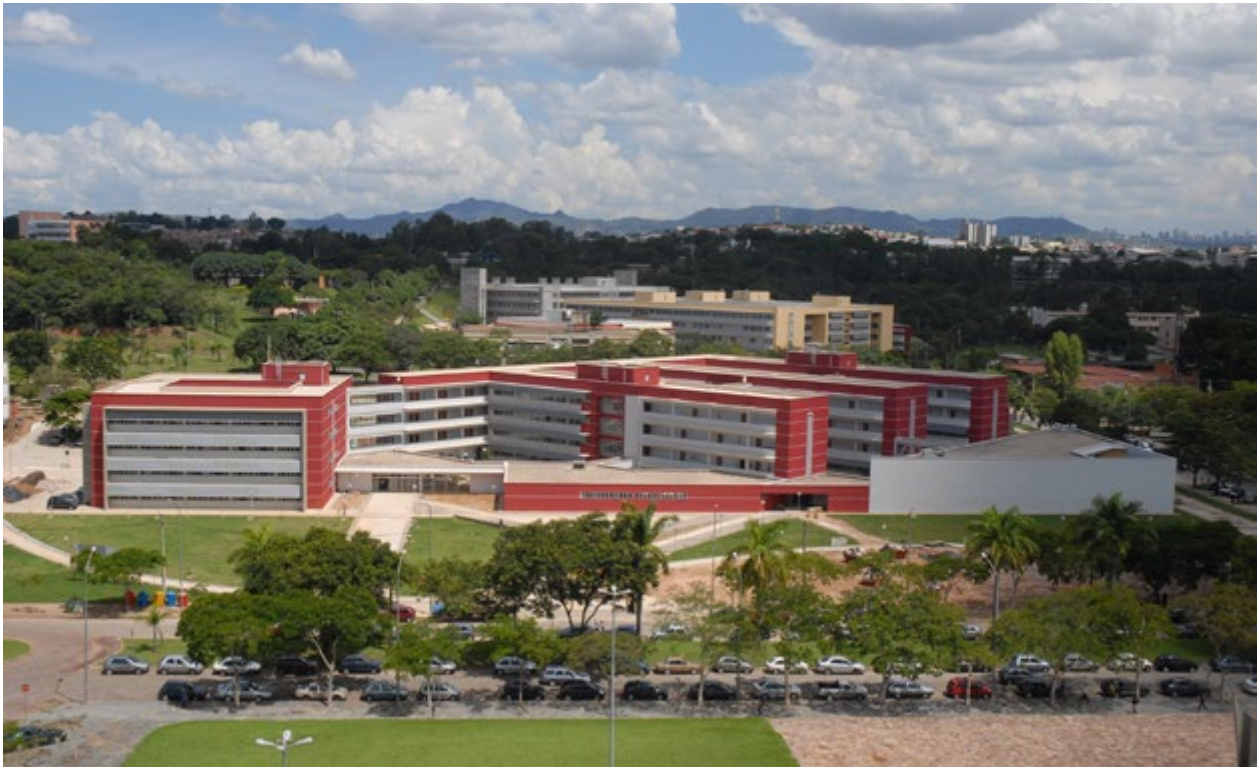
Prédios da Universidade Federal de Minas Gerais (UFMG). Autor desconhecido. Fonte: http://alfenasagora.com.br
