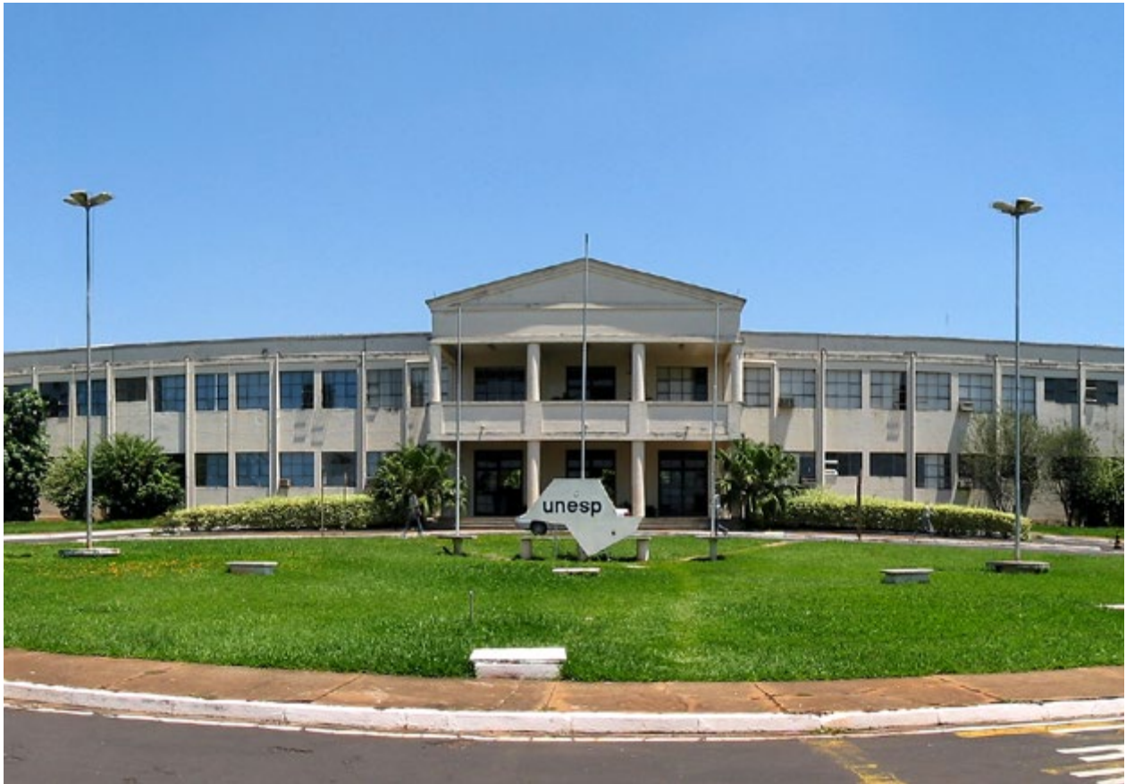
Prédio Universidade Estadual Paulista Júlio de Mesquita Filho em São José do Rio Preto. Autor desconhecido. Fontes: https://projektorosachoque.wordpress.com/
