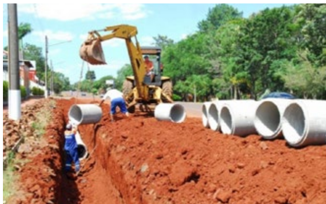
Obra de saneamento básico em Vitória da Conquista. Autor desconhecido. Fonte: bahianapolitica.com.br
