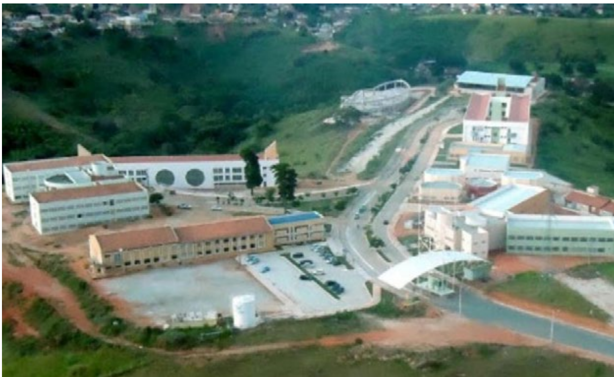
Foto aérea das obras da Universidade dos Vales de Jequitinhonha e Mucuri. Autor: Desconhecido. Fonte: jornaldosvales.com.br
